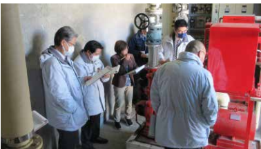
中学校消防設備改修工事の現地調査 (中原中学校)
