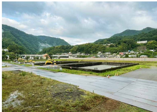
現在の半原水源跡地
