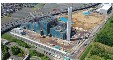
建設中のごみ中間処理施設 (厚木市金田)
