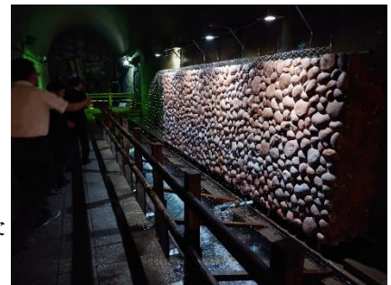
高森湧水トンネル
