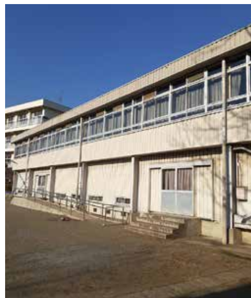
指定避難所の半原小学校体育館
