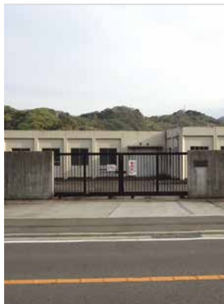
浸水対策が急がれる戸倉浄水場
