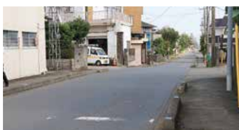
町道中津2969号線の舗装を打ち換え
