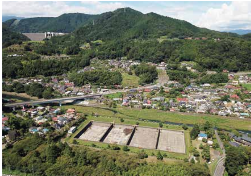
上空から見た横須賀水道半原水源跡地
