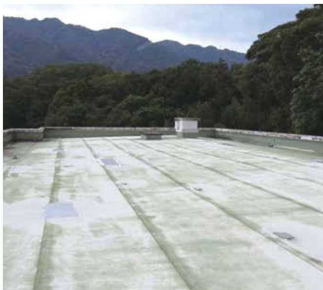
屋上防水シートを改修（愛川中学校）
