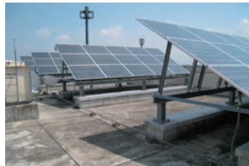
町消防庁舎の太陽光発電設備
