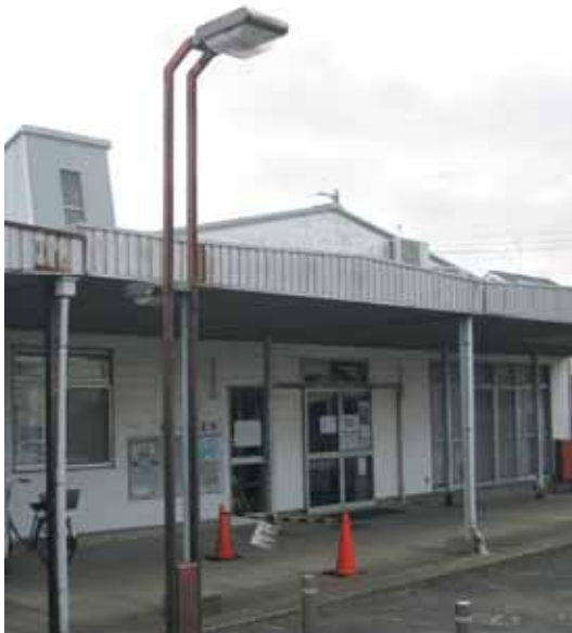
今年度屋根を改修した春日台児童館
