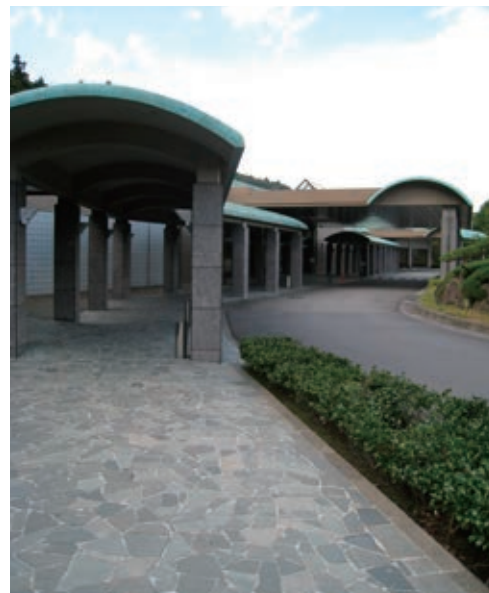
大規模改修工事を行った愛川聖苑
