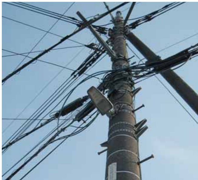
試験的に設置されたLED防犯灯（中津地内）
