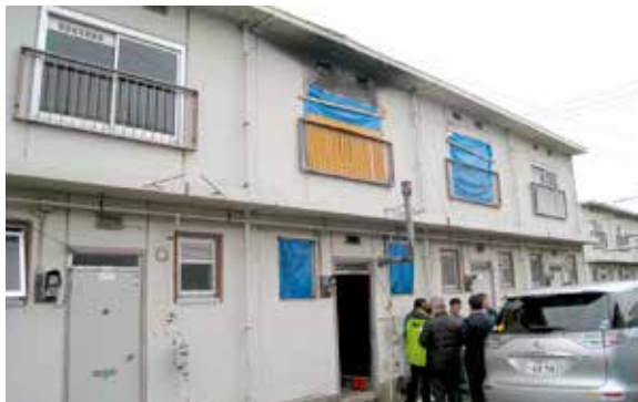
火災のあった町営桜台住宅を調査
