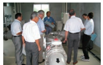
戸倉浄水場を調査
