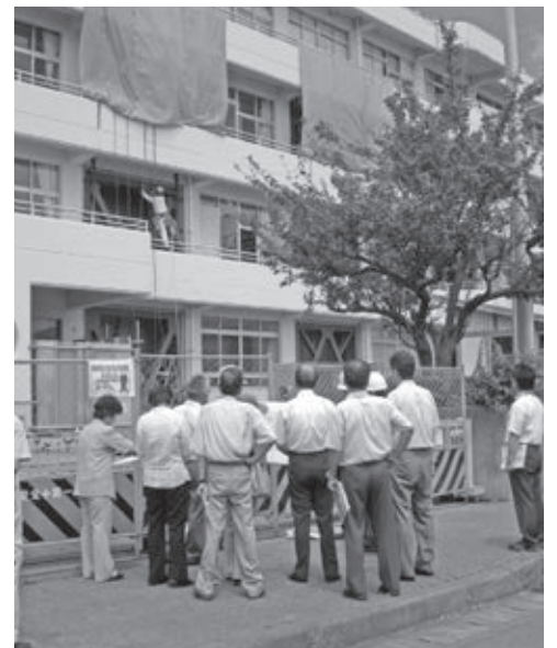
菅原小学校校舎耐震補強工事の調査
