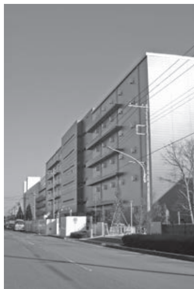
建設中の建屋（内陸工業団地）
