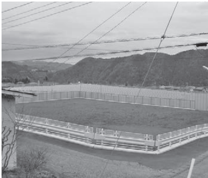
整備中の県メガソーラー施設に隣接する 愛川ソーラー観光広場整備予定地
