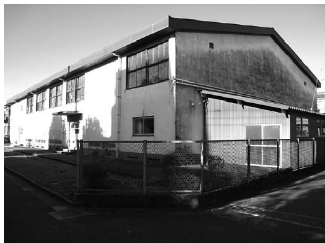
本年度解体工事が行われる町立体育館 ＝愛川東中学校北側
