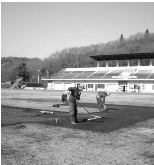
シルバー人材センターの作業委託 ＝三増陸上競技場
