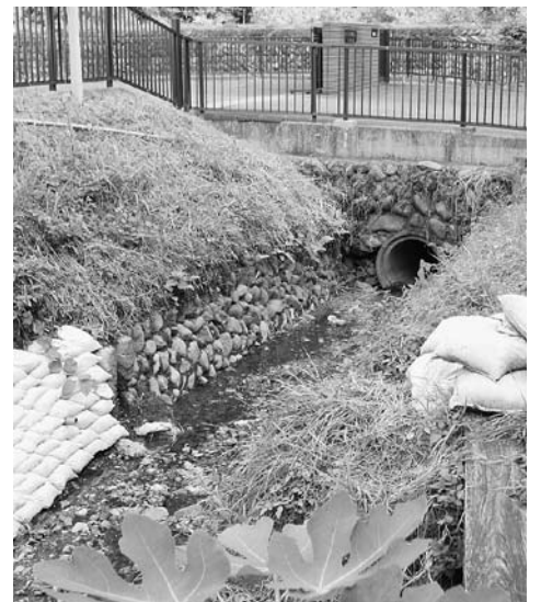
県道54号(相模原・愛川線)金山橋前 ＝半原原白地内
