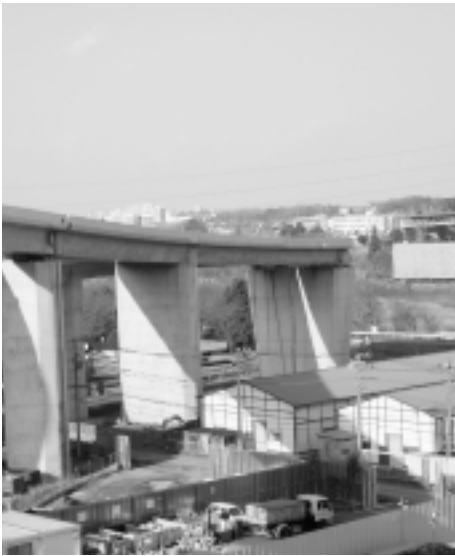
建設中のさがみ縦貫道路
