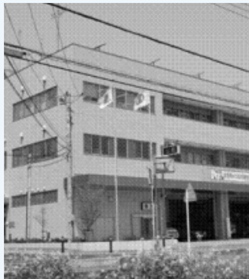
平成17年3月完成の新消防庁舎
