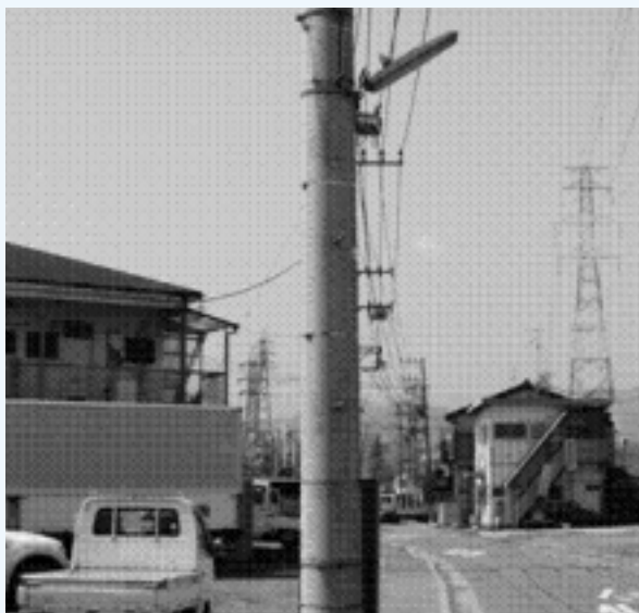
現在の防犯灯＝中津六倉地内
