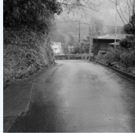
町道半原202号線＝半原川北横根地内
