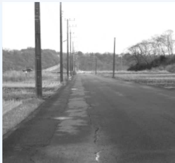
町道幣山・下平線＝角田幣山地内
