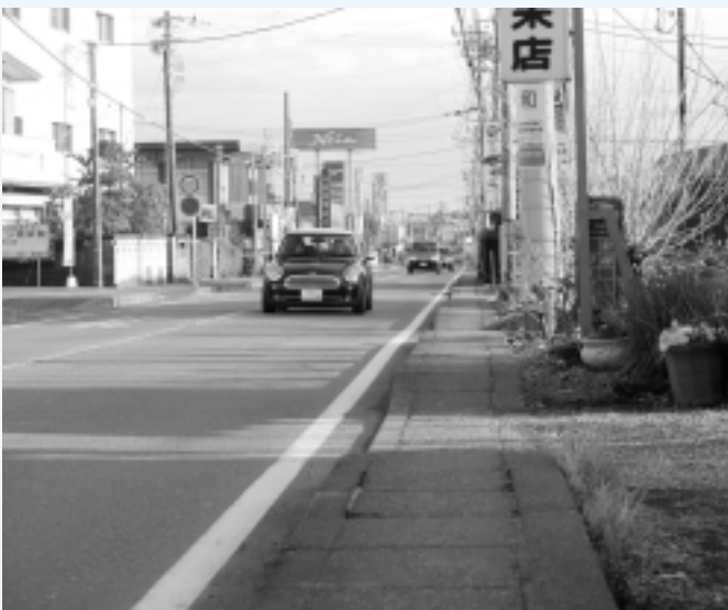
歩道が未整備の県道相模原大磯線 ＝中津熊坂地内
