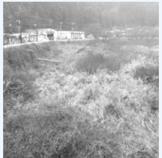
草刈り等が望まれる中津川河川敷 ＝半原隠川地内
