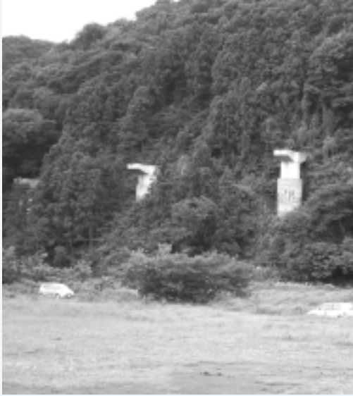
建設中の幣山・下平線
