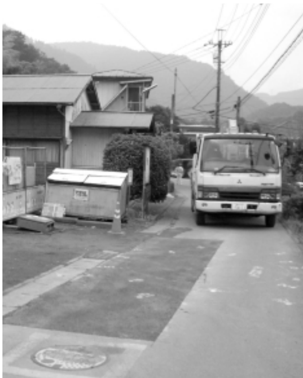
公共下水道工事 =半原地内
