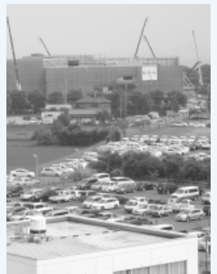
建設中の物流センター ＝角田梅沢前
