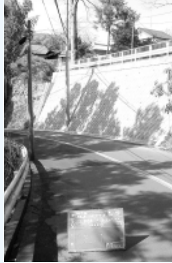
一部整備が完了した三増馬渡線西坂法面整備
