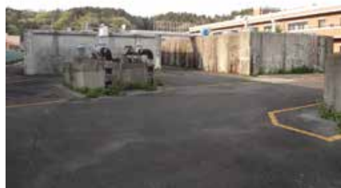
町の基幹浄水場である戸倉浄水場
