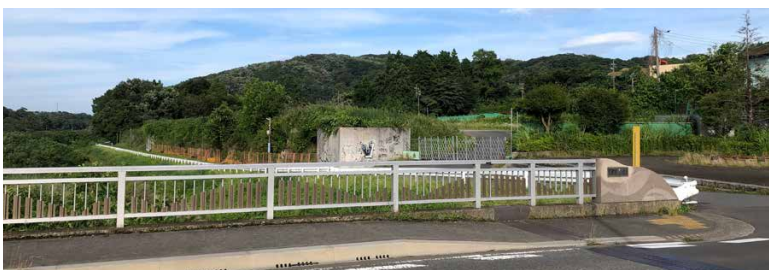
工事が予定されている平山大橋付近の様子
