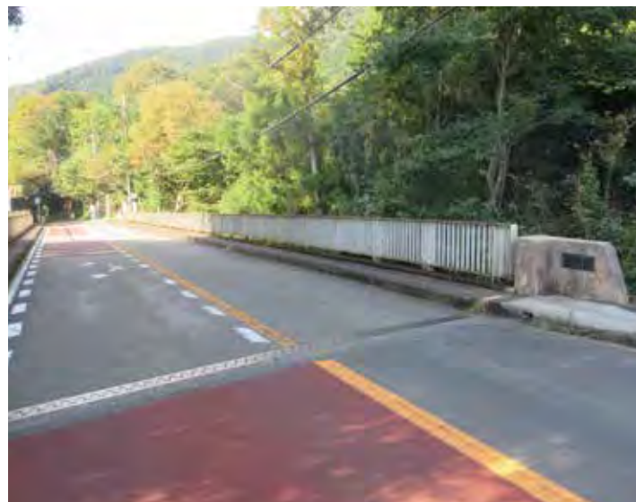
1970年に完成した原白橋(半原地内)防護柵の塗装をはじめ、床版や橋台のコンクリート部材の断面修復などを行います
