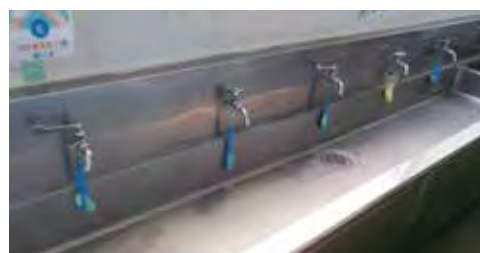
小中学校の水道の蛇口を回転式から接触の少ないレバー式へ変更しました
