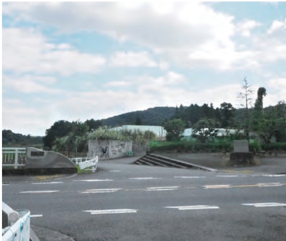
平山大橋付近から見る 平山下平線の整備予定地
