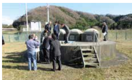
戸倉浄水場の現地を調査
