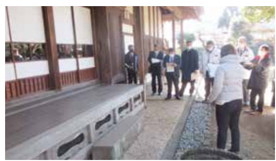
古民家山十郎縁側等修繕の現地調査
