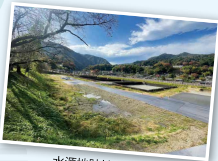
水源地跡地工事中
