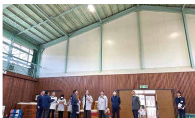
中津小学校校体育館照明器具 LED化改修工事の現地調査
