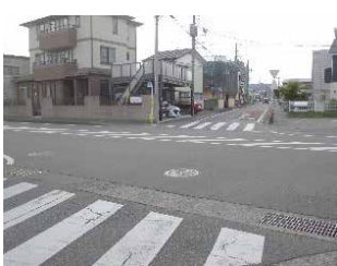
交差点のカラー舗装工事が実施されます。
