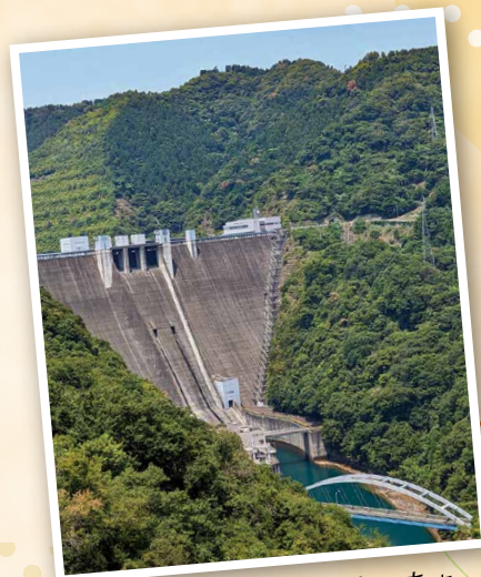
放流している所をみたいなあ ～宮ヶ瀬ダム～
