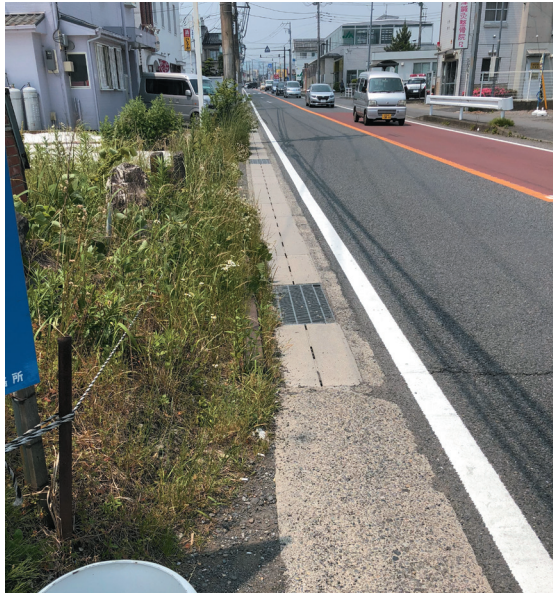
一本松歩道橋付近の状況
