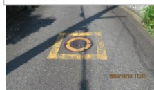
消火栓の表示が消えている
