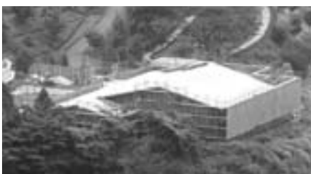
建設中の郷土資料館（県立あいかわ公園内）
