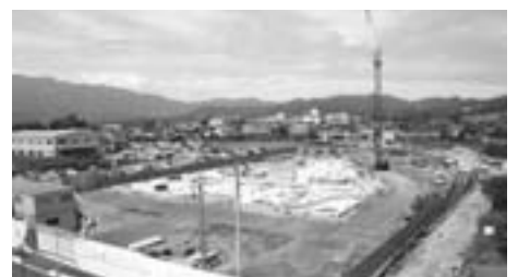
愛川北部病院建設中の役場北側敷地
