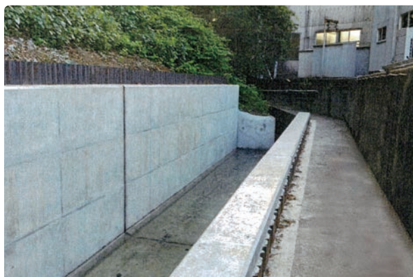
中津大塚下地区の水路整備工事
