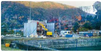
既存建物の撤去
