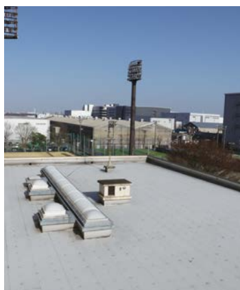
第1号公園体育館屋上
