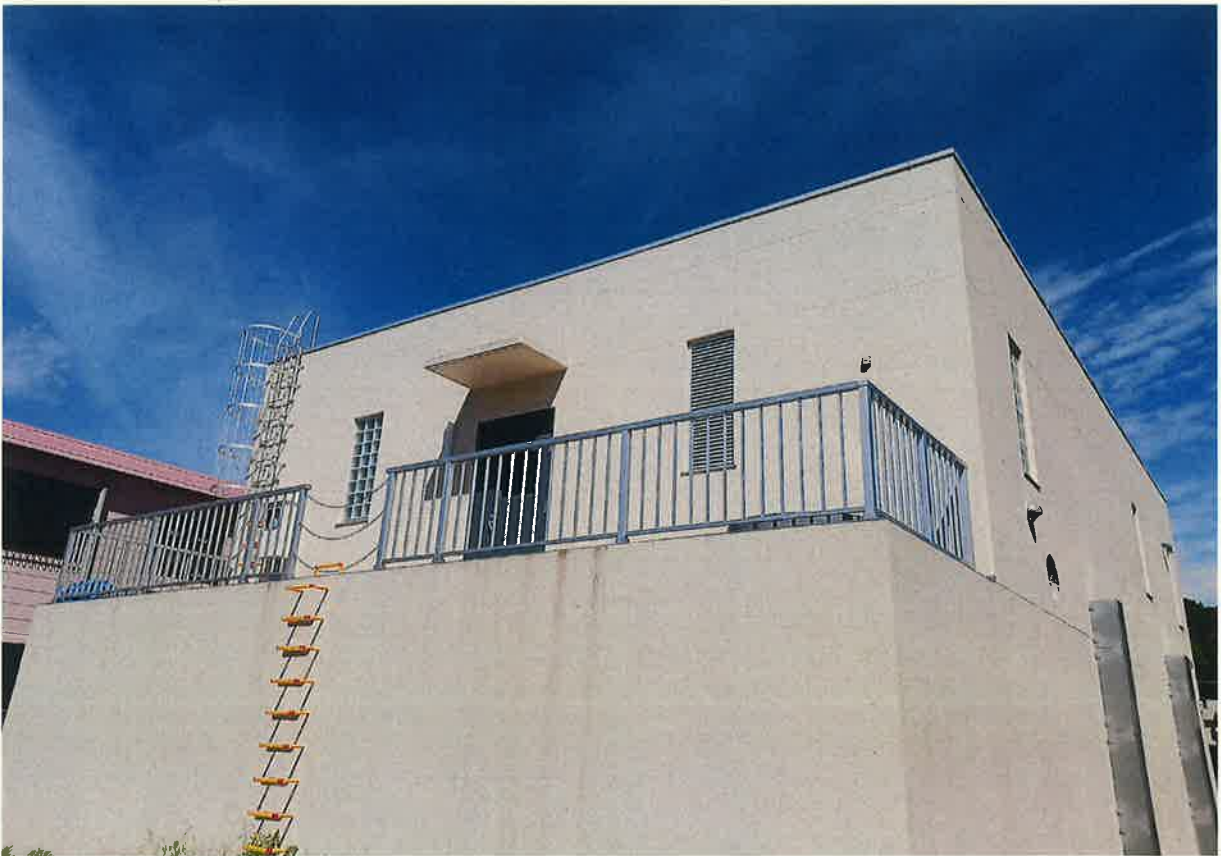
(戸倉浄水場第2浄水池)
