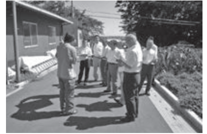
道路改良工事現地調査(中津地内)
