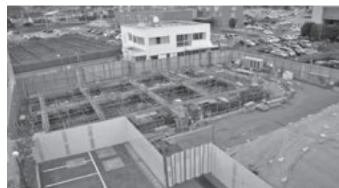
新保健センター建設工事現場
