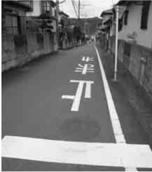
住宅街に敷設された道路外側線
