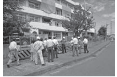
菅原小学校耐震補強工事現場
