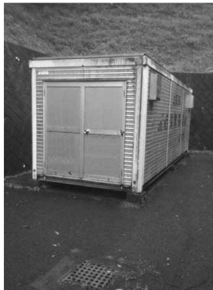
コンテナ式備蓄倉庫
