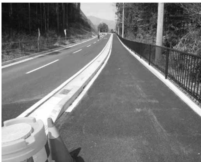
幣山下平線歩道整備箇所
