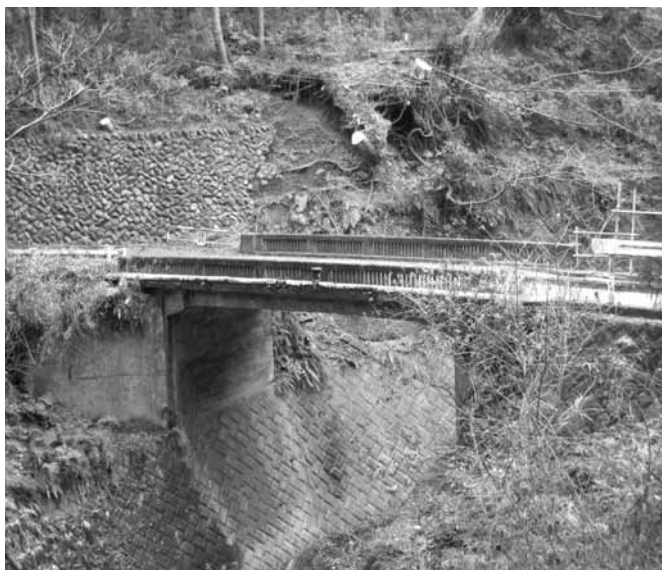
中細野橋下の「板橋」
