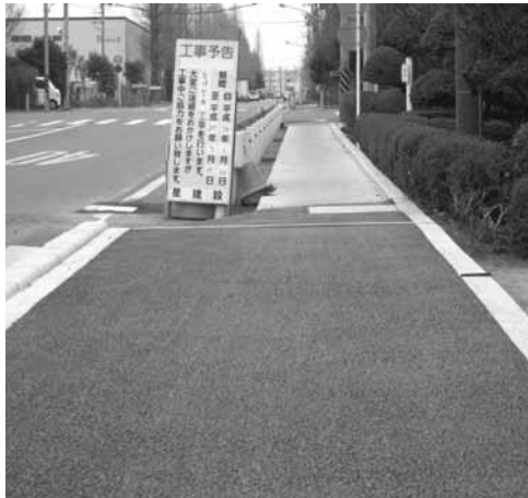
中津228号線の歩道整備工事
