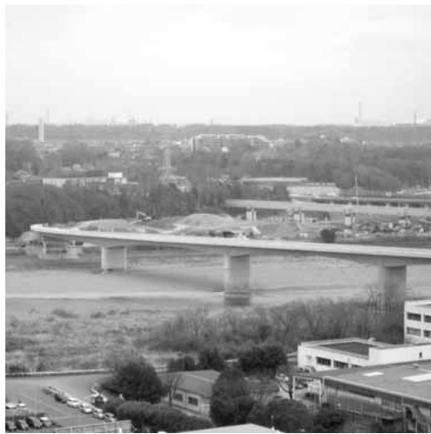
(仮) 相模原 I C 付近のさがみ縦貫道路
