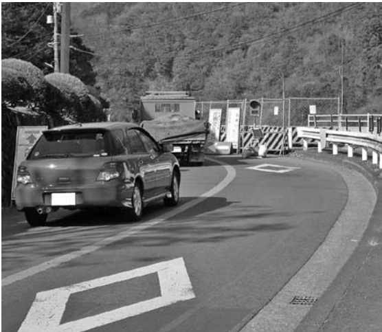
早期工事完成が望まれる 人道橋の復旧工事
