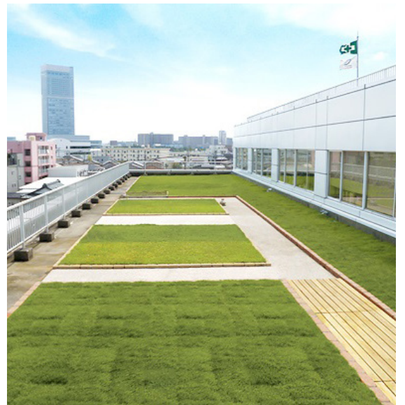
屋上緑化の例
