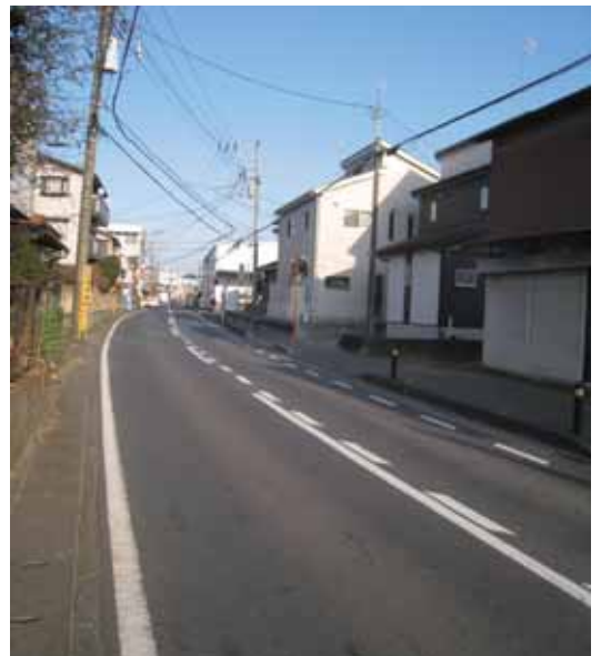
中津小学校付近の道路
